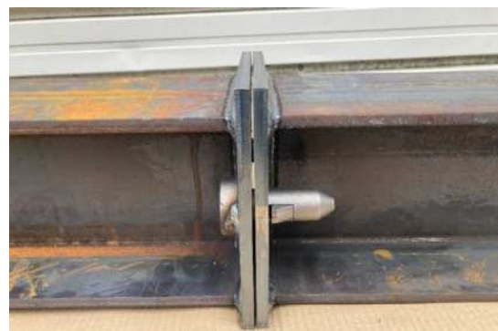
〈支保工連結状況〉
